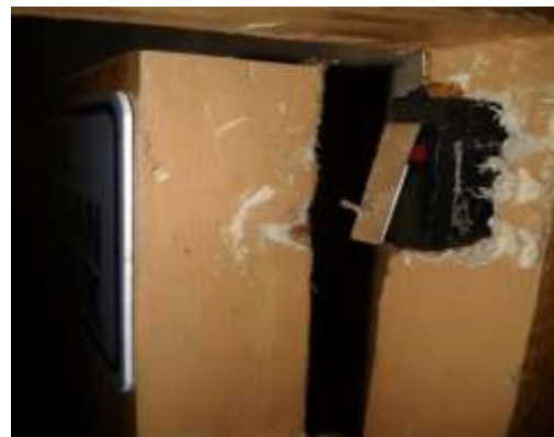
Gambar 27 Pintu ruang sandi terbuka.
